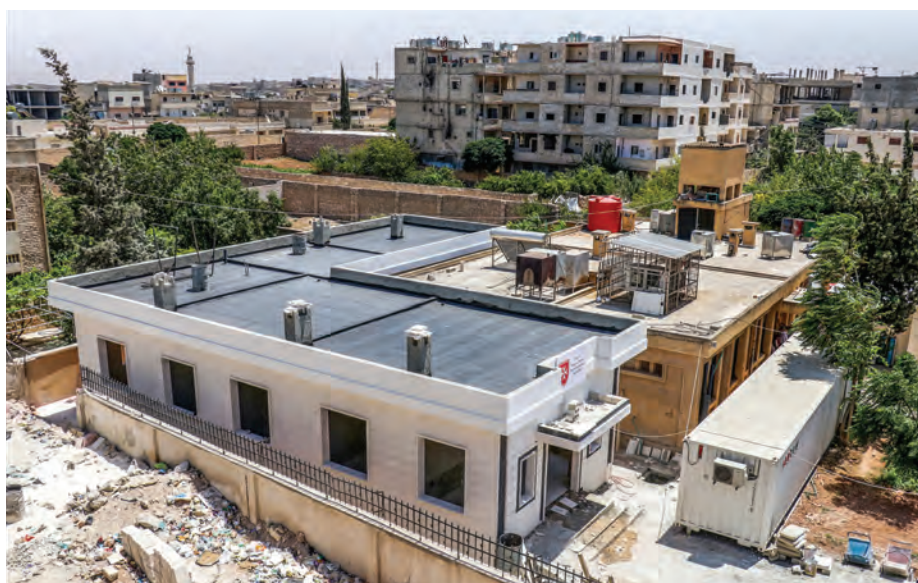
Az épülő máltai kórház Aleppó Al-Nayrab negyedében
